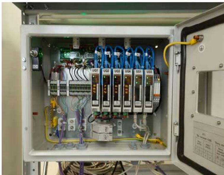
Рисунок 4 - Внешний вид шкафа комплекса виброконтрольного
